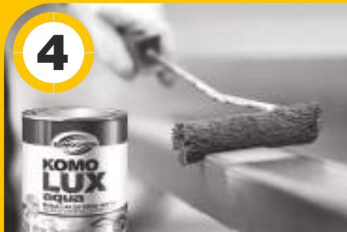
Sa finim brusnim papirom **prebrusiti sloj temeljnog premaza**, zatim nanijeti prvi sloj KOMOLUX aqua premaza. Sa finim brusnim papirom **prebrusiti** prvi sloj KOMOLUX aqua premaza, zatim **nanijeti drugi sloj**.
