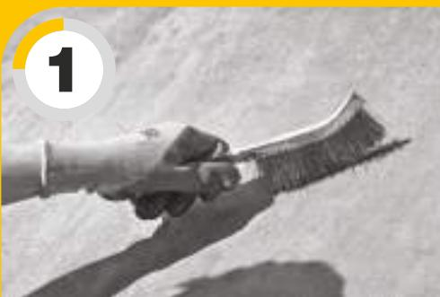
Prije nanošenja temeljnog premaza potrebno je **odstraniti korozione proizvode** mehanički (ručno ili mašinski) čeličnom četkom ili brusnim papirom granulacije P-80, P-100 ili P-120, zatim je potrebno **otprasiti obrušenu koroziju**.
