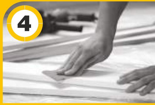
Sa finim brusnim papirom prebrusiti prvi sloj KOMOLUX aqua premazu prije nanošenja drugog sloja radi uklanjanja podignutih drvenih vlakana, zatim nanijeti drugi sloj.
