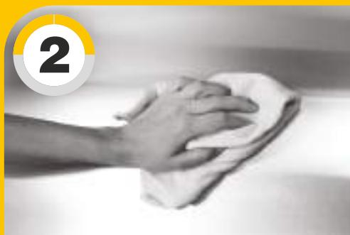
**Podlogu je potrebno odmastiti** KOMOCHEM Nitro razrijedivačem, alkoholom ili nekim drugim sredstvom za odmašćivanje. Nakon odmašćivanja **podlogu prebrisati suhom pamučnom krpom** tako da nakon brisanja ne ostane nečistoće na krpi.
